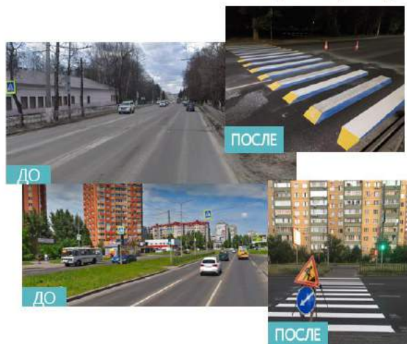
Нанесение горизонтальной дорожной разметки на улицах города Курска
